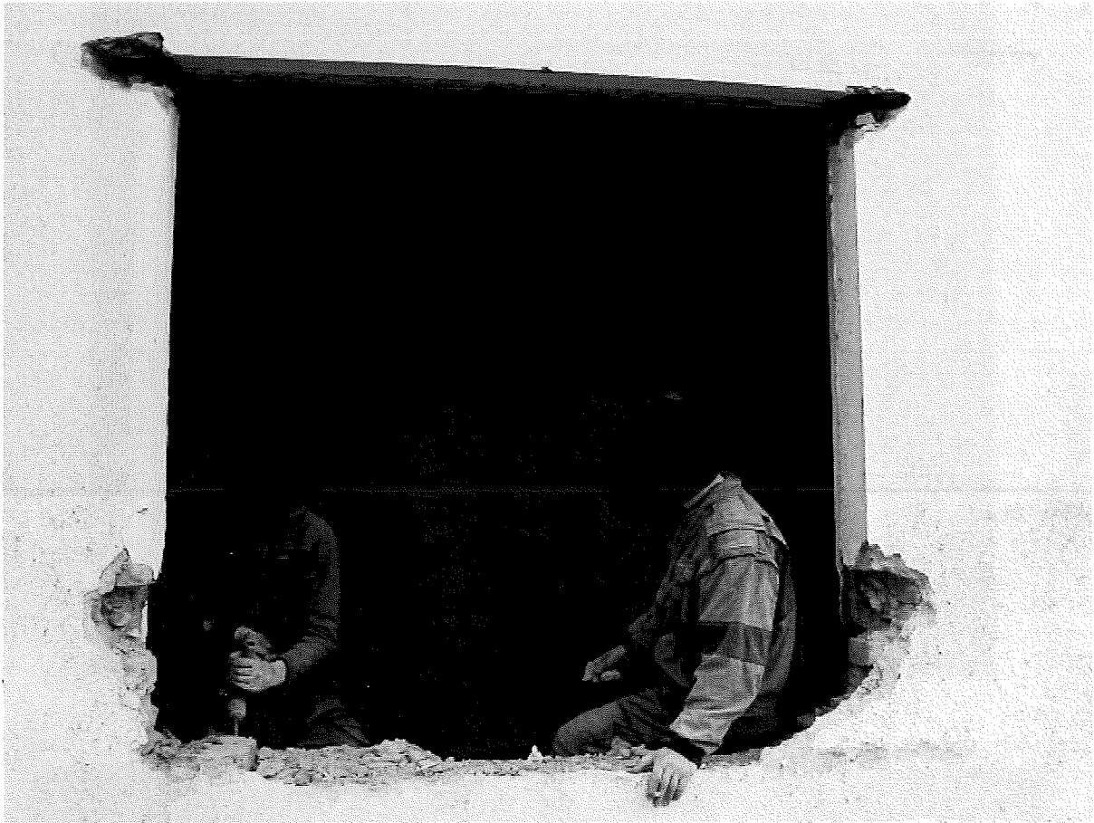
Pracovníci VPP pomáhají s rekonstrukcí budovy Obecního úřadu.
