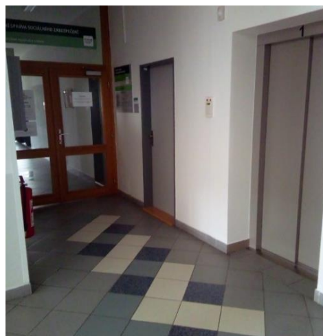
Vstupní dveře do chodby
