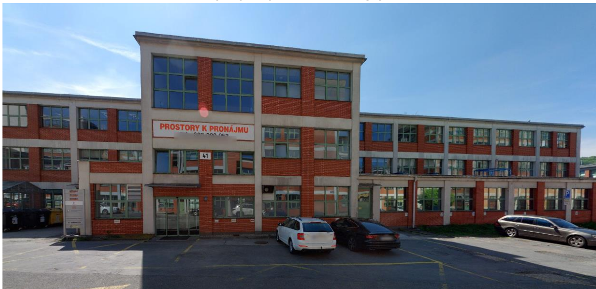
CELKOVÝ POHLED NA HLAVNÍ VSTUP
