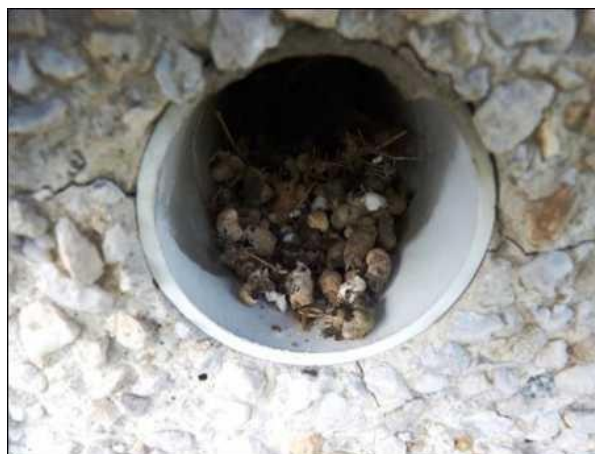
Trus drobných pěvců v ústí ventilačního otvoru
