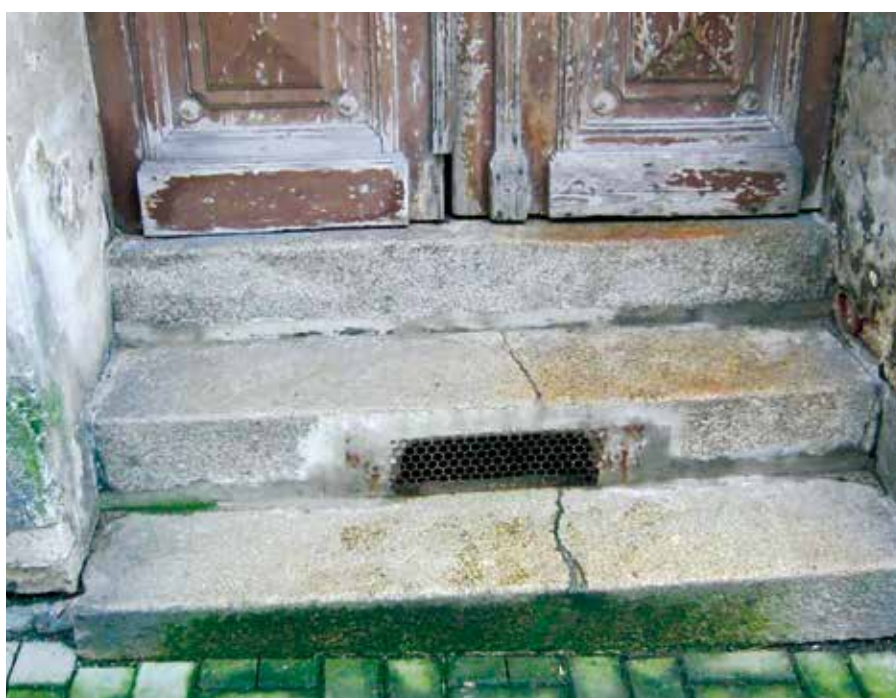
Schody jsou jednou z příčin izolace seniora
