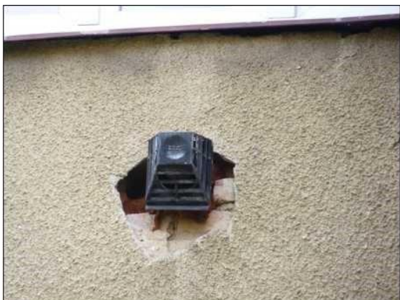
Nezačištěné okraje odvětrání podokenního hnízdiště rorýse obecného
