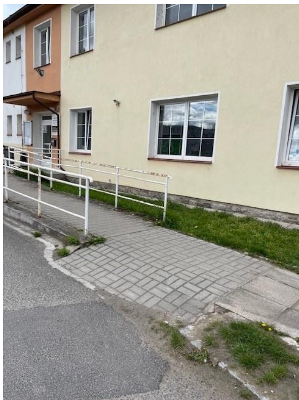
Nájezdová plošina ke vstupu do budovy
