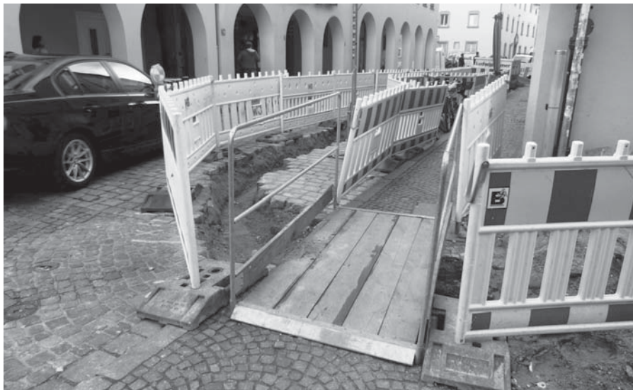
Příklad zajištění výkopu ve městě
