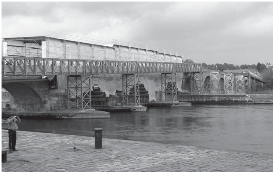
Pomocný most umožňující bezpečné provádění restauračních prací bez ovlivňování zaměstnanců procházejícími stavenišťem
