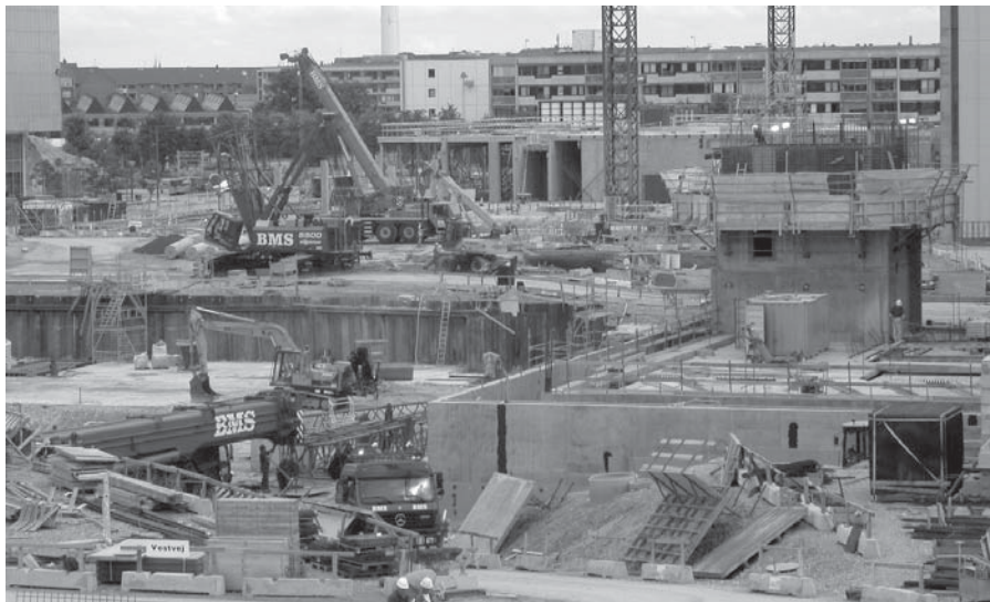
Pohled na bezpečné staveniště komplexu státních budov v Kodani 09/2004
