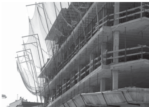
Příklad používání záchytné sítě k zajištění BOZP při práci ve výšce
