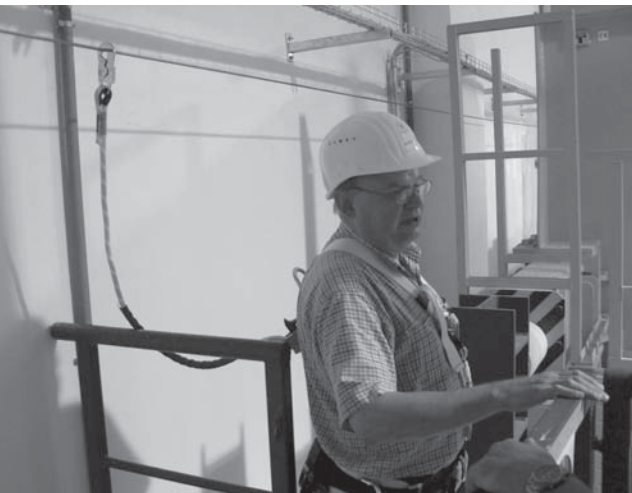
Ukázka zajištění při pohybu po jeřábové dráze
