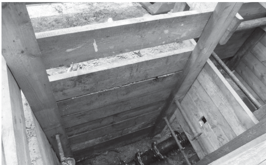
Příklad zapaženého výkopu
