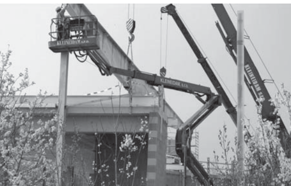
Příklad práce na montážní plošině umožňující dopravu montážníků do těžko přístupných míst
