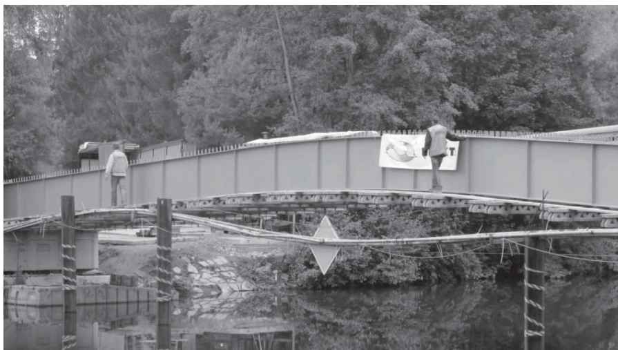
Pomocný most umožňující bezpečné provádění restauračních prací bez ovlivňování zaměstnanců procházejícími stavenišťem
