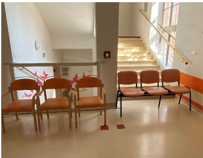
obr. 9: Příklady nevhodného vybavení chráněných únikových cest
