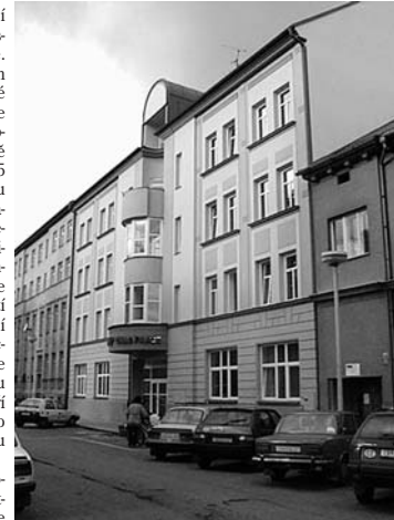
Budova Úřadu práce v Českých Budějovicích
